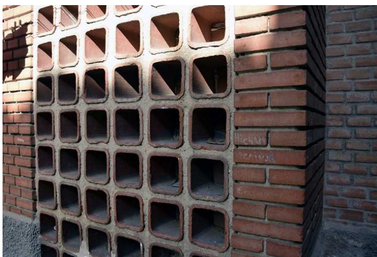
Ilustración 10. Detalle de cerramientos de las galerías en los bloques de viviendas de RENFE en Villaverde Bajo, Madrid.
