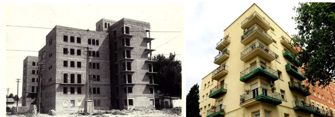
Ilustración 1. Edificio RENFE junto a la estación de Valencia-Alameda en construcción y en su estado actual.
